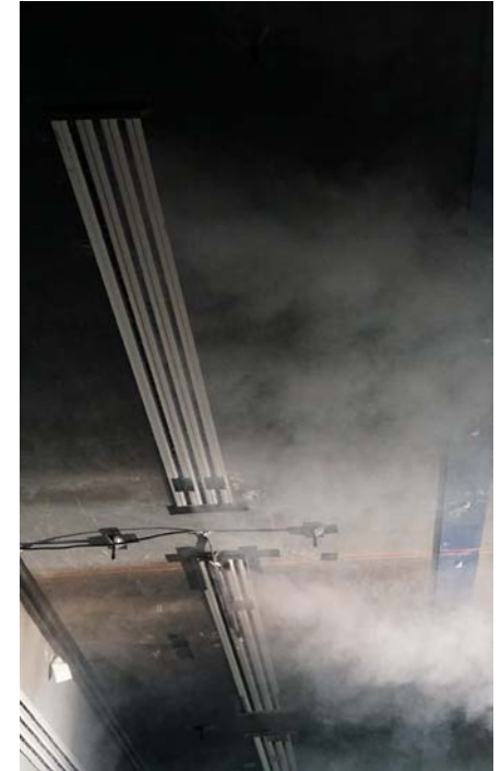
Zuluftdurchlass mit Kaltnebelzufuhr
